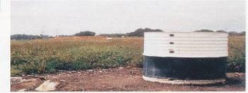
ガス抜き設備の効果により、植生が回復
