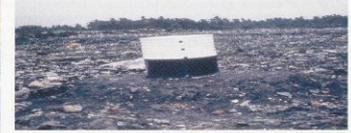
廃ドラム缶を使ったガス抜き設備
