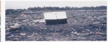
廃ドラム缶を使ったガス抜き設備
