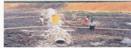
竹や廃ドラム缶を使った循環式堆肥気性埋立地
