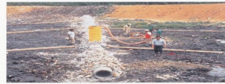
竹や廃ドラム缶を使った簡易式準好気性埋立地
