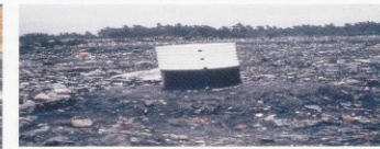
廃ドラム缶を使ったガス抜き設備
