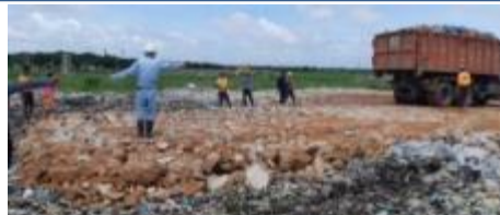
Instruction technique sur la réception des déchets et les travaux de mise en décharge
